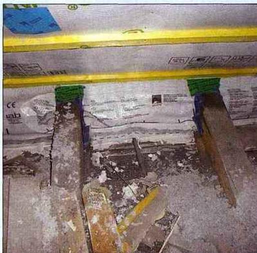
L'insuffisance de ventilation sur le chantier a donné lieu à un phénomène de condensation sur ces têtes de solives.
